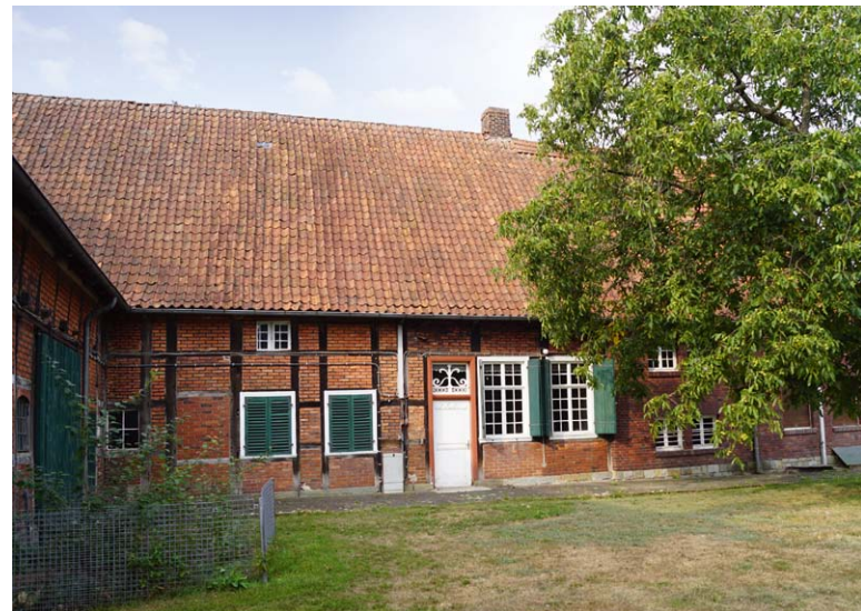
Denkmalgeschützter Kernbereich (östliche Ansicht)
